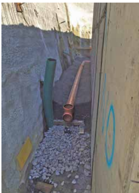
Figure 6.86 (à gauche): Détail du drainage de radon.
