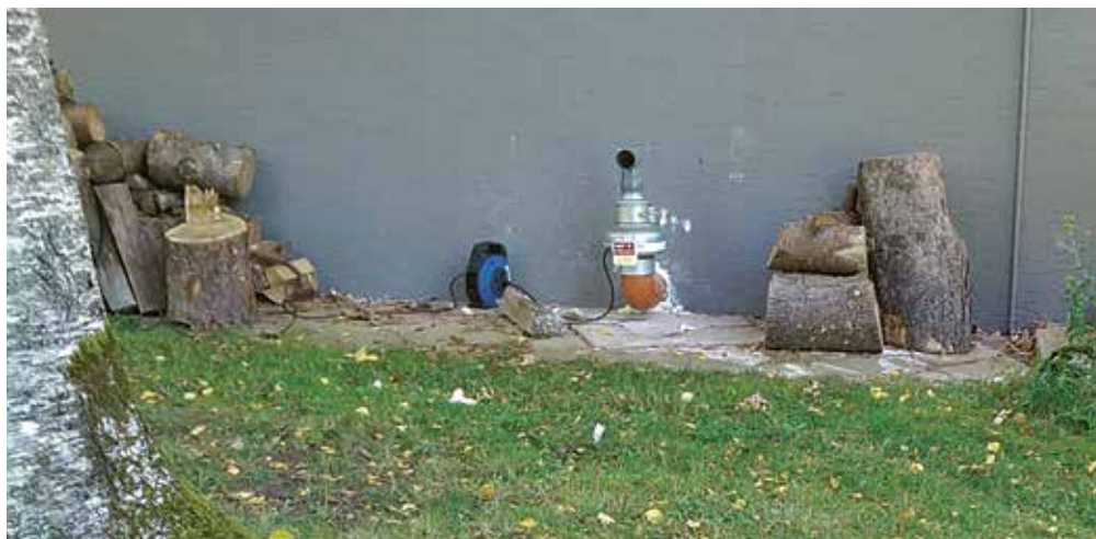
Figure 6.55 : Installation temporaire d'un puisard.
