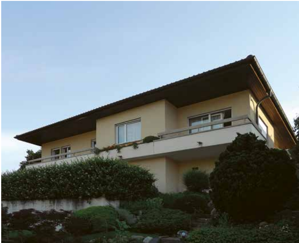
Figure 6.12 : Un vide sanitaire se trouve sous la maison familiale.
