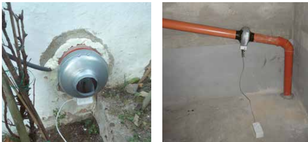
Figure 6.13 : Après avoir testé la ventilation du vide sanitaire (à gauche), un puisard intérieur a finalement été installé (à droite).
