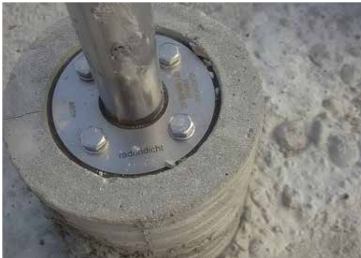
Figure 6.100 : Passage de tuyau bridé étanche au radon.
