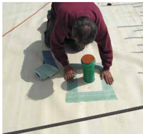
Figure 4.14 (à droite) : Détail relatif à l'étanchement d'un passage mural pour tuyau avant le coulage du radier (source : Sika).
