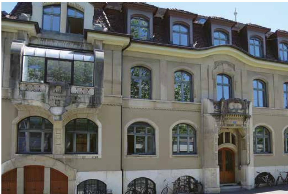
Figure 6.72: Le bâtiment historique date de 1903.
