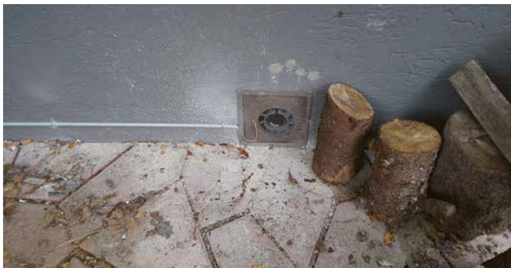
Figure 6.56 : Montage définitif du puisard.
