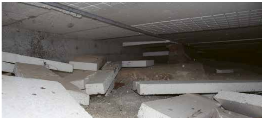
Figure 6.63 : Un vide sanitaire est situé sous le bâtiment du jardin d'enfants (en haut).
