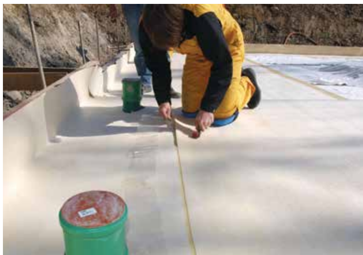
Figure 4.10 (en bas à droite) : Étanchement externe des murs du sous-sol par des bandes d'étanchéité (source : Sika).
