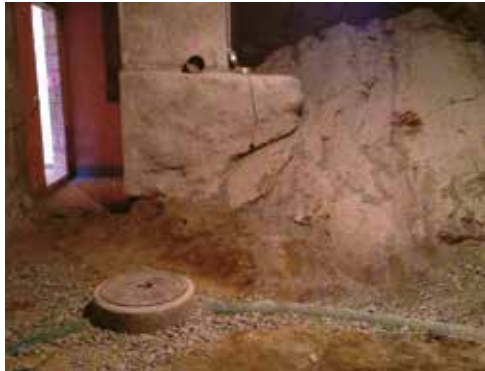
Figure 6.26 (à gauche): Puisard et tuyau de drainage: à l'arrière, on aperçoit la roche apparente.
