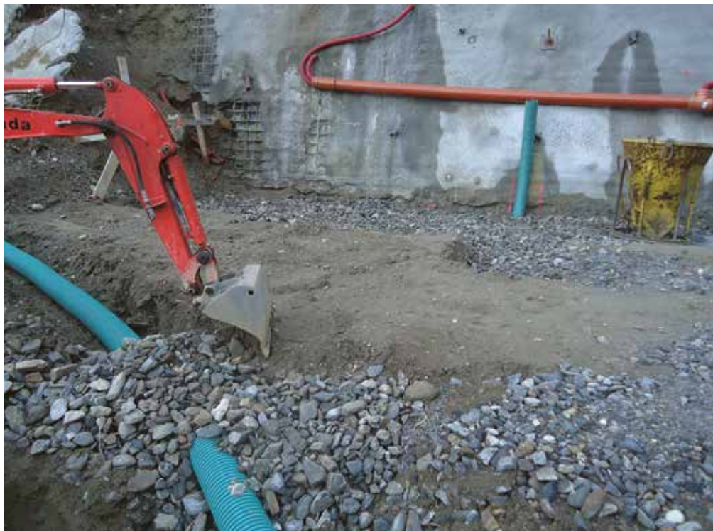
Figure 6.85 : Installation d'un drainage de radon.
