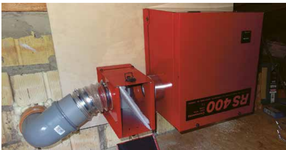
Figure 6.23: Pour des raisons de place et afin d'empêcher les émissions de bruit dans les chambres à coucher, un tuyau de ventilation a été monté à l'extérieur du bâtiment.
