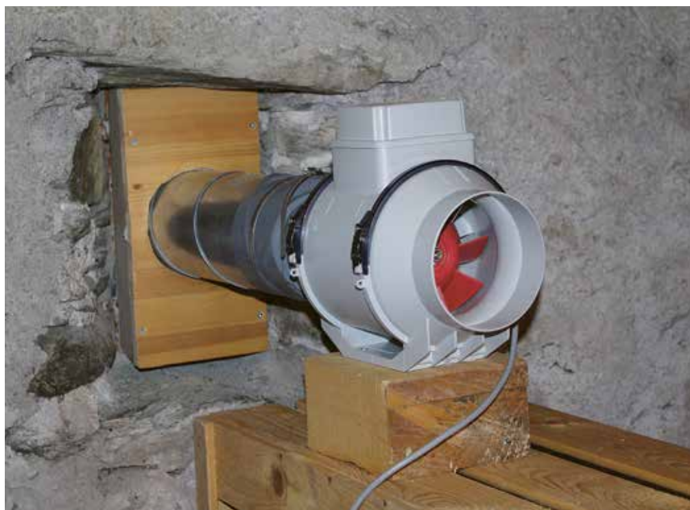
Figure 6.39 : Au moyen d'un ventilateur, l'air de la cave en terre battue est transporté à l'air libre. L'air à forte concentration de radon ne peut donc plus pénétrer dans les locaux d'habitation.
