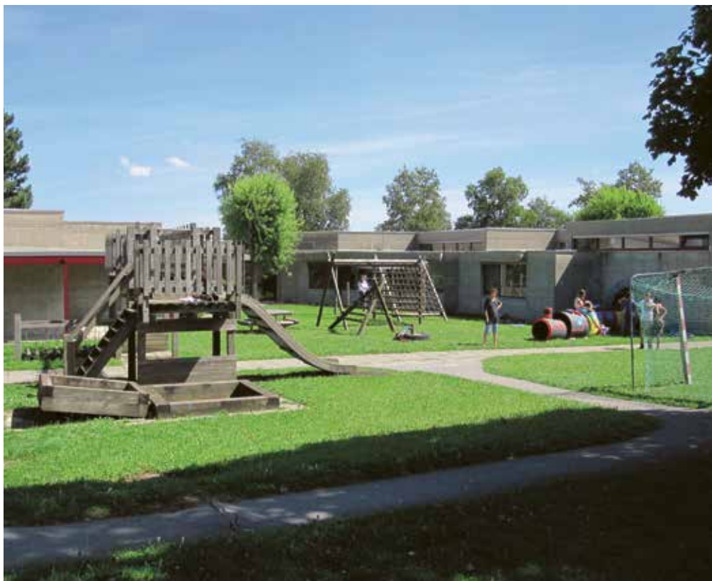
Figure 6.47 : Le bâtiment scolaire a été construit en béton à la fin des années 1960.
