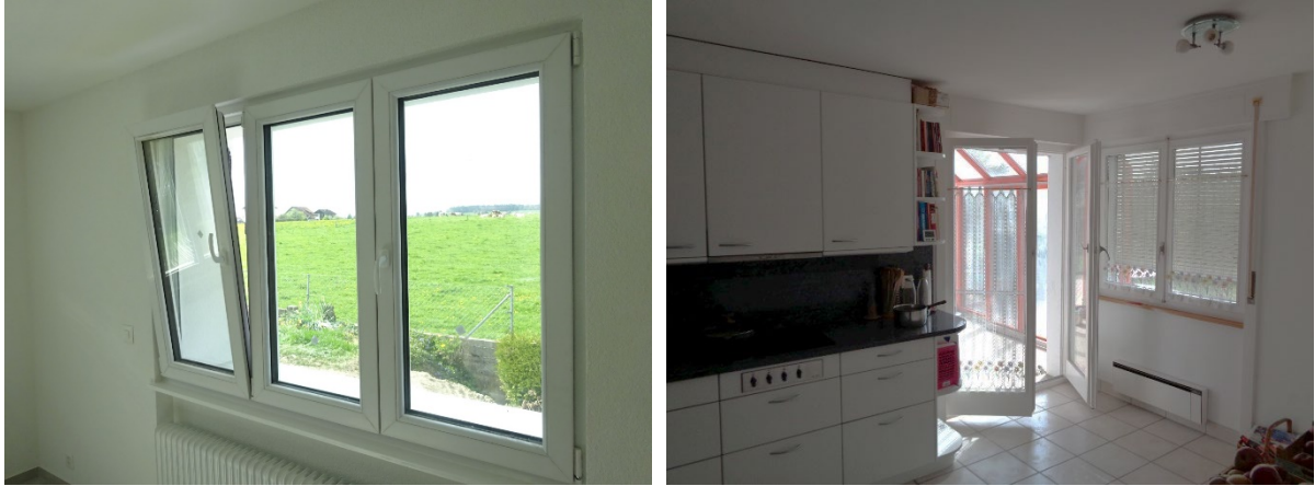
A gauche, ouverture en imposte : aération peu efficace. A droite, ouverture « à la française » : aération efficace (photos : ©Effiteam Sàrl)
