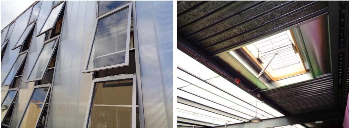
A gauche, fenêtres avec ouvrant motorisé en façade. A droite, fenêtre de toit avec ouvrant motorisé en toiture (photos : ©Effiteam Sàrl)
