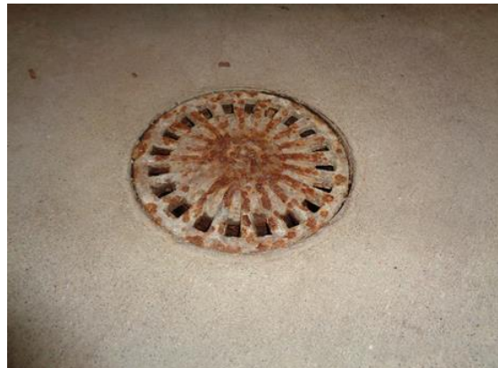
Siphon de sol étanche grâce au clapet anti-retour (invisible sans retirer la grille en fonte). Evite les remontées de radon et d'odeurs par les écoulements peu ou pas sollicités dont les siphons sèchent et permettent ainsi un contact direct entre les canalisations et la pièce concernée. (détail : croqAIR, HEIA-FR ; photo : ©Effiteam Sàrl)
