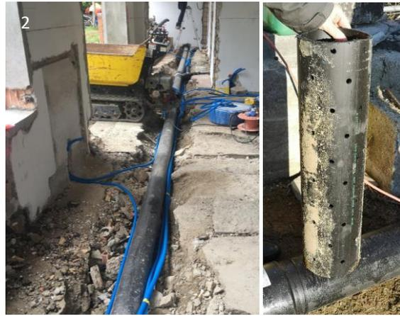
**1** : Ventilateur d'extraction du radon pour un puisard dans un regard à l'extérieur. **2** : drainage avec tube perforé en polyéthylène (PE) dans la partie enterrée lors d'une rénovation (photos : ©Econs SA).
