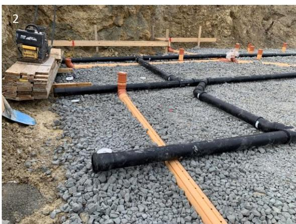
**1 et 2** : Drainage radon en polyéthylène (PE, noir) sur un lit de verre cellulaire, avec le drainage séparé pour l'eau en-dessous en polypropylène (PP, jaune). Vue des tubes noirs non perforés avant la pose des coudes pour monter vers les regards de curage (photos : ©croqAIR, HEIA-FR).
