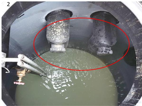
**1 et 2** : Tubes avec coudes plongeurs pour un drainage mixte eau et radon. Longueur de la partie verticale insuffisante dans le regard, le tube doit être immergé d'au moins 30cm dans l'eau pour assurer une dépression efficace. Si le tube n'est pas immergé en permanence, de l'air sera aspiré depuis le regard et il n'y aura pas de dépression efficace dans le terrain (photo : ©croqAIR, HEIA-FR).
